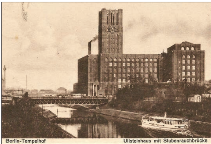
Berlin-Tempelhof Ullsteinhaus mit Stubenrauchbrücke Stubenrauchbrücke in den 1930er Jahren
