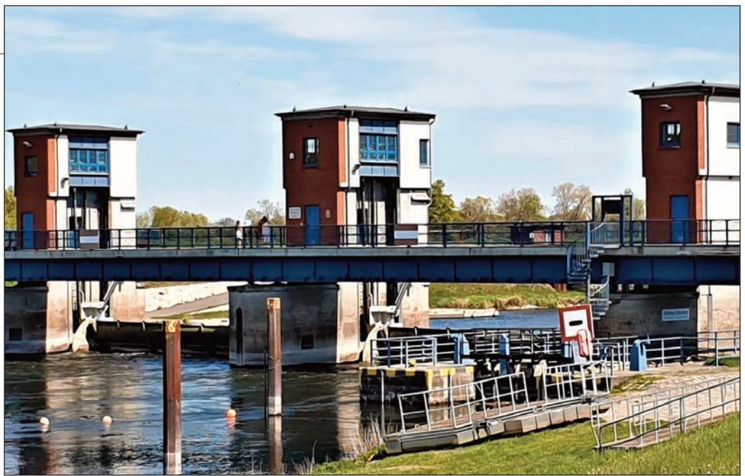
Wehranlagen in Gnevsdorf, die auch dem Hochwasserschutz dienen.
