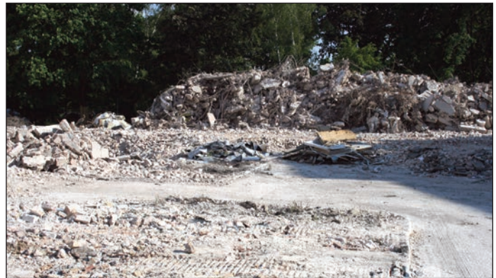
Auf diesem Trümmerhaufen liegen die Überreste von ehemaligen Lager- und Technikräumen des Pflegeheims.
