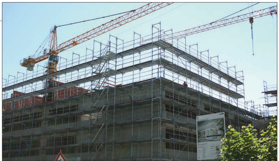
Der Robbau der Gustav-Heinemann-Oberschule. Drei von vier Stockwerken sind schon fertiggebaut, alles ist eingerüstet. Foto: Bothe
