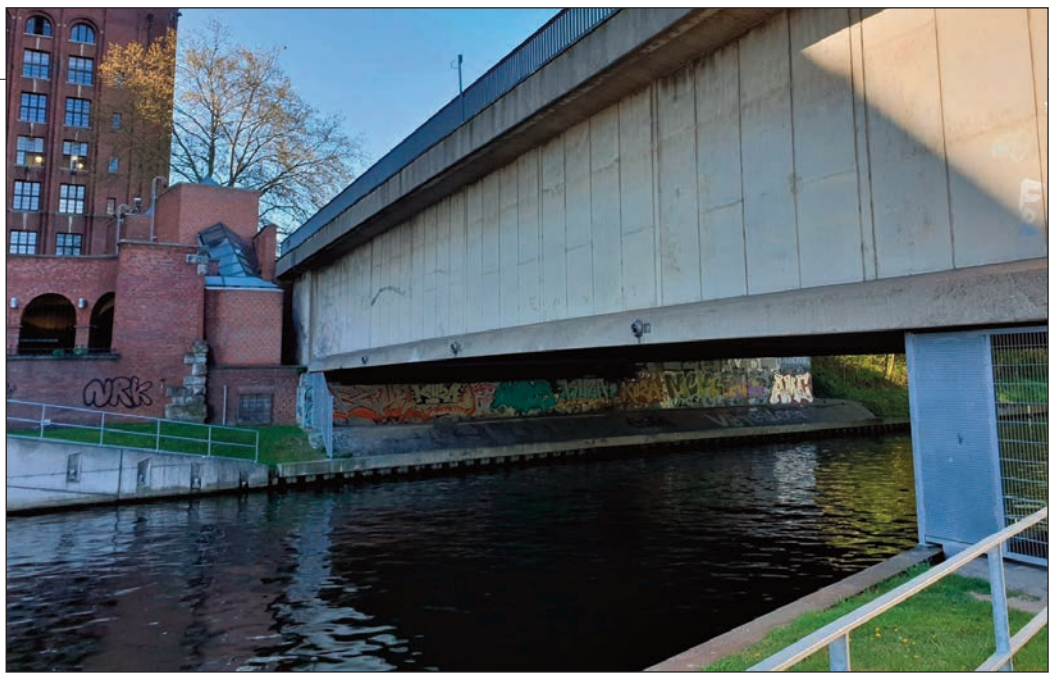
Der östliche Brückenabschnitt der Stubenrauchbrücke in Tempelhof mit U-Bahnkasten unterhalb der Brücke
