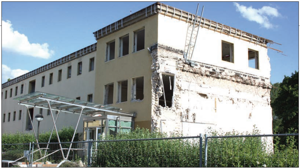
Der ehemalige Haupteingang zum „Haus Louise Schröder“: Alle Fensterscheiben sind raus, ein Anbau schon abgerissen. Ein Zaun sichert die Baustelle. Fotos (2): Bothe
