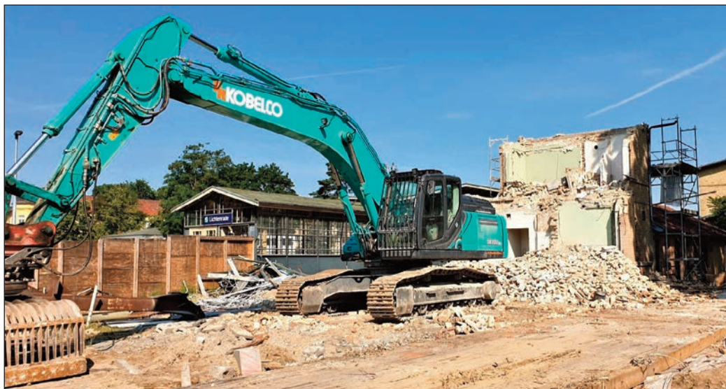
Die Bagger bei der Arbeit: Der Abriss des Bahnhofshäuschens ist beendet.
