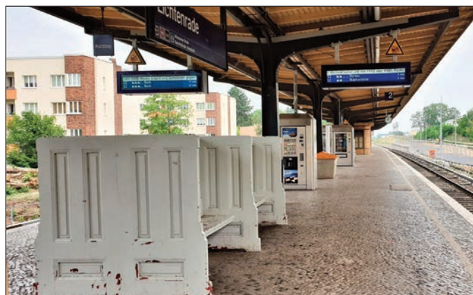
Die Bänke auf dem alten Bahnhof Lichtenrade werden wieder auf dem künftigen Bahnhof zu finden sein.
